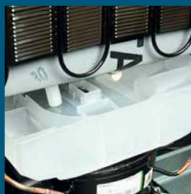
► Der Auslass leitet das Wasser in eine äußere Schale, in der es nach und nach verdunstet.
